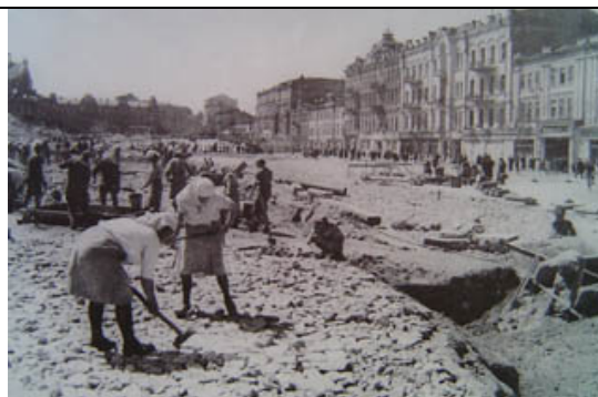
Киев. Строительство коммуникационного коллектора на Крещатике. 1944г.
