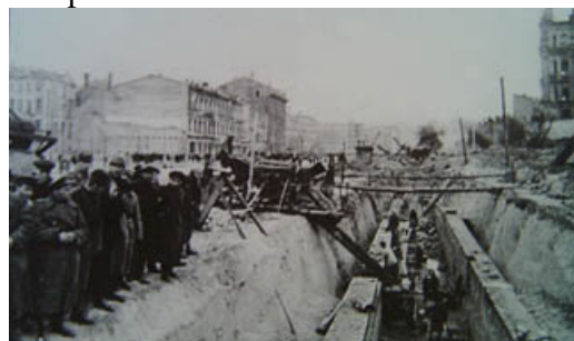
Киев. Строительство коммуникационного коллектора на Крещатике. 1944г.
